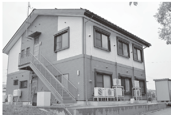
(改修したGHいぶぎ外観)
