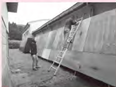
▲建物の雪囲い設置完了
